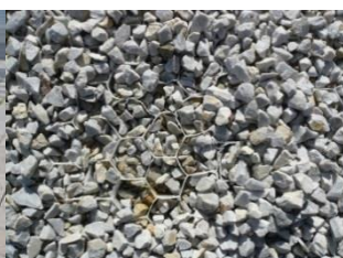
Structure nid d'abeille avec gravillons
